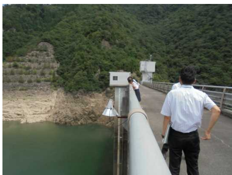
大河内発電所で使用する下部ダム
